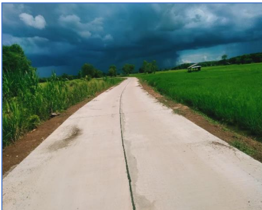
ภาพถ่ายดำเนินการแล้วเสร็จ
